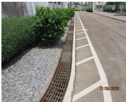
ภาพที่ 2.1-5 รางระบายน้ำฝนภายในโครงการ
