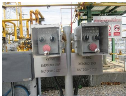
ภาพที่ 2.1-28 อุปกรณ์ตัดแยกระบบอัตโนมัติ
