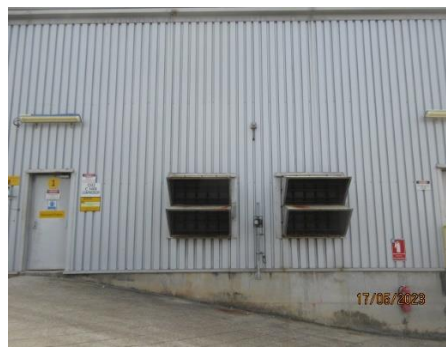
ภาพที่ 2.1-8 ติดตั้งอุปกรณ์ลดเสียง
