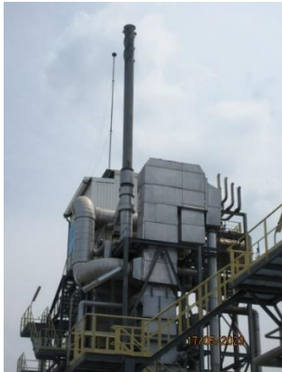
ภาพที่ 2.1-1 ปล่อง Reformer furnace
